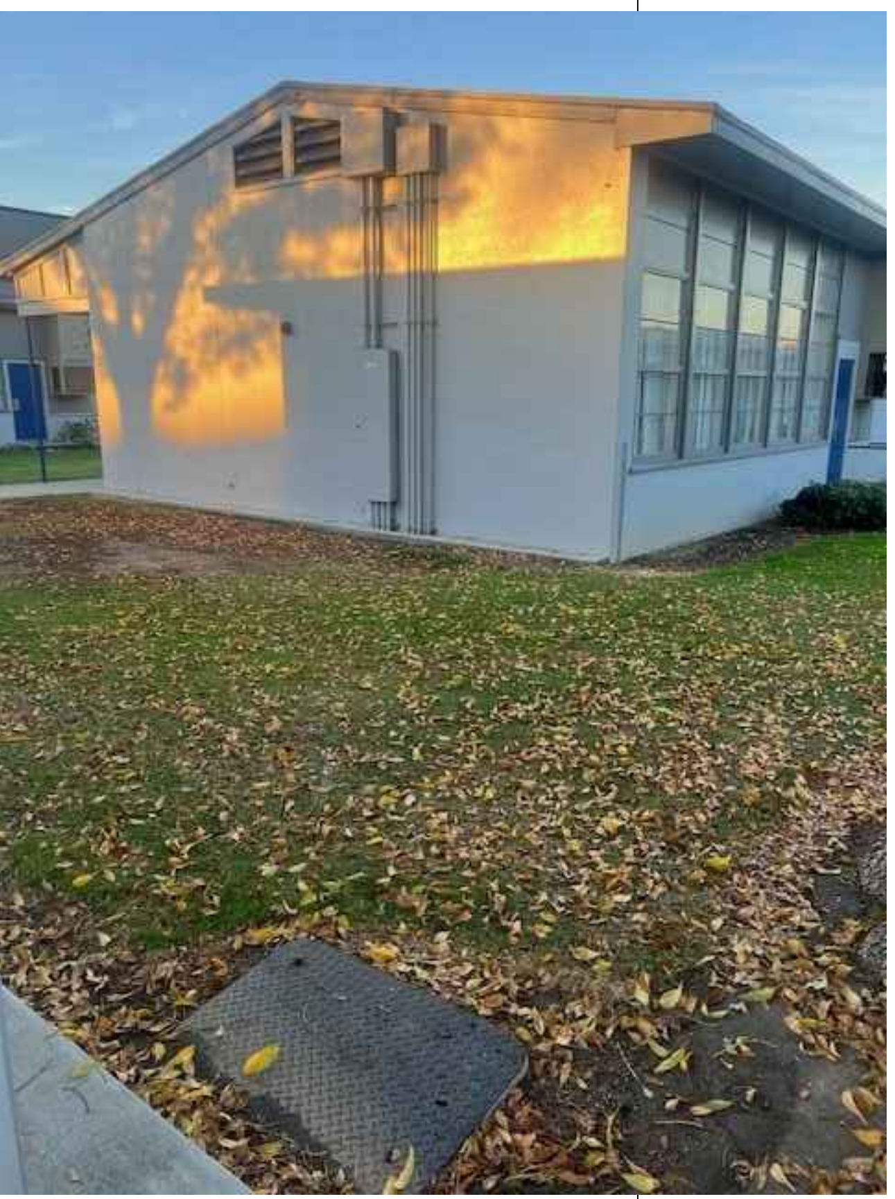
EXISTING CONDUIT RISER PICTURE ②
